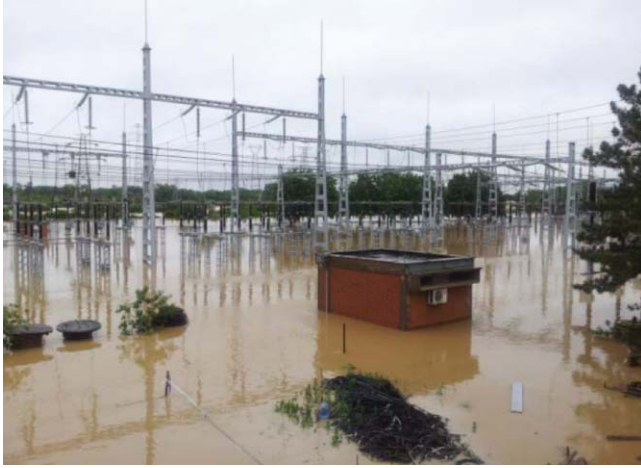
Slika 1. Poplavljena TS 400/220 kV Obrenovac
