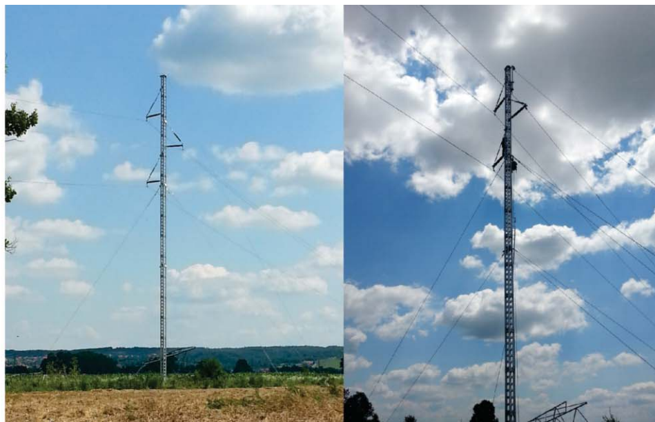
Montažno demontažni stub
